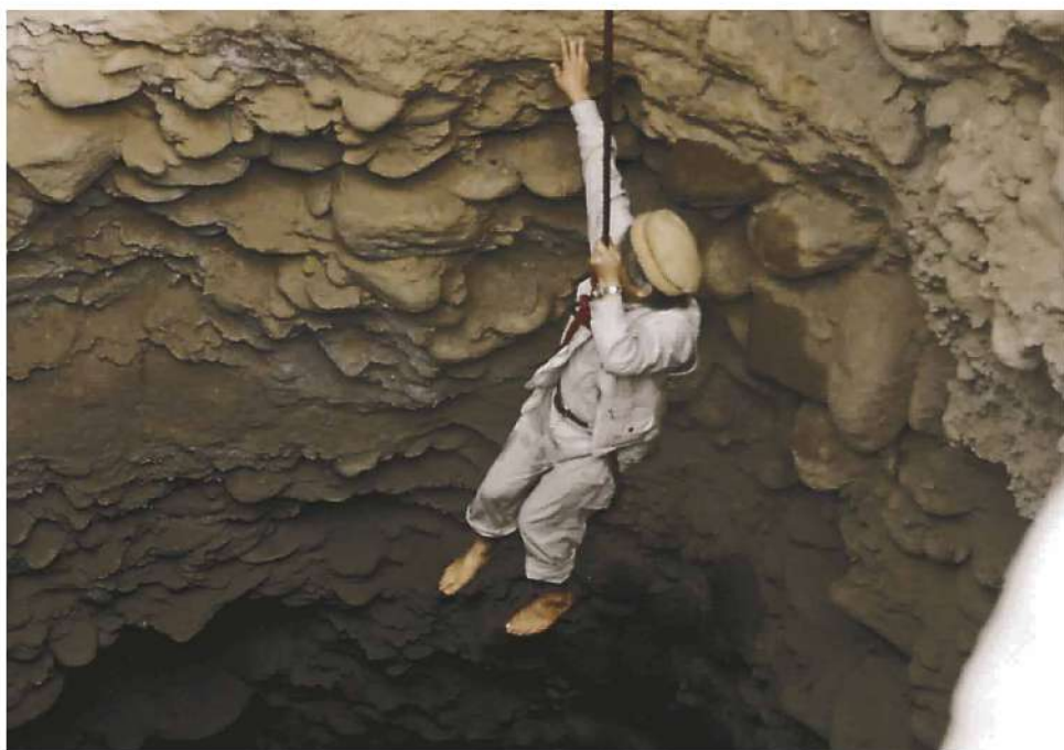
地面の下にある水をくむための井戸。工事をしている中村先生も深くはった穴の中におりていきました。=PMS提供
